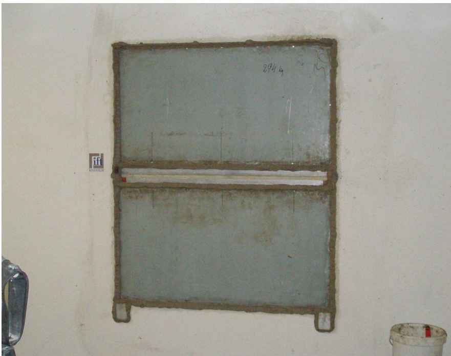
Bild 3 Foto des eingebauten Elementes (erstellt vom ift Schallschutzzentrum)
