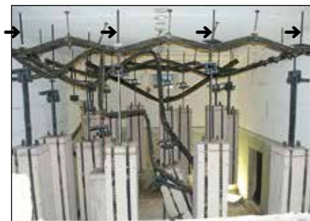
Mehrfelddurchlaufträger mit Einzellasten, nach der Brandprüfung → = Verformungsmessung
