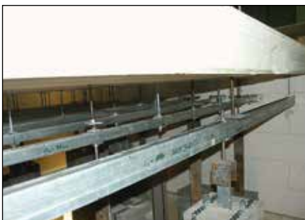
Mehrfelddurchlaufträger mit Einzellasten, vor der Brandprüfung
