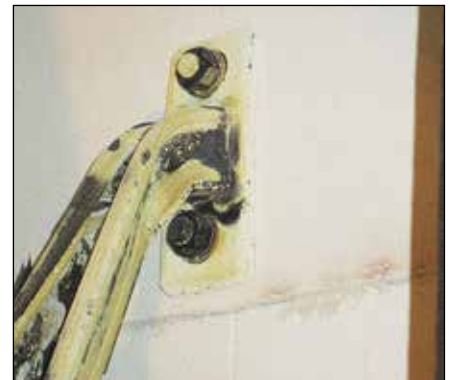
Konsole MQK nach der Brandprüfung, stark verformt
