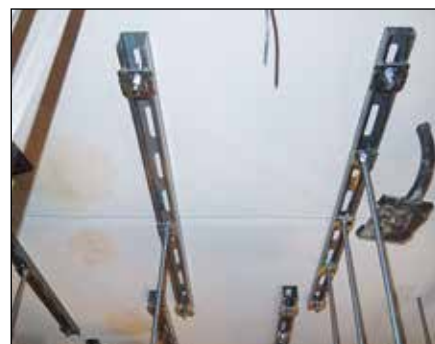
Direktmontierte Schiene mit Einzellast
