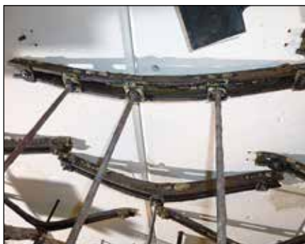
Direktmontierte Schienen MQ-21 bzw. MQ-41, Stützweite 700 mm
