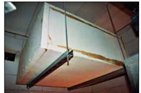
Biegesteifer Kanal aus Promatect LS Platten, vor der Brandprüfung
