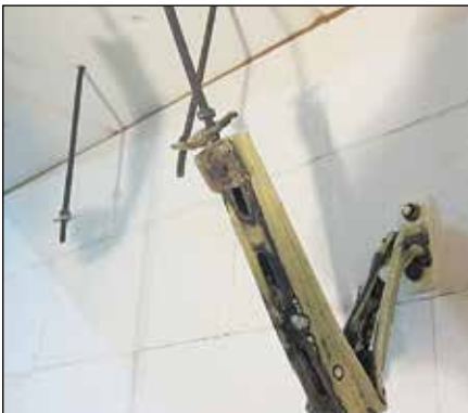
Konsole MQK mit mittiger Einzellast, nach der Brandprüfung
