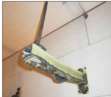
Konsole MQK mit mittiger Einzellast, nach der Brandprüfung, Ausriss der Lastanbindung (MQA) aus der Schiene
