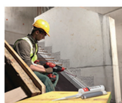
Kotwienie końcowe schodów do ściany
