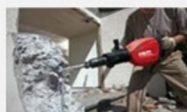
Wiercenie i rozbiórka
