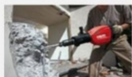
Wiercenie i rozbiórka
